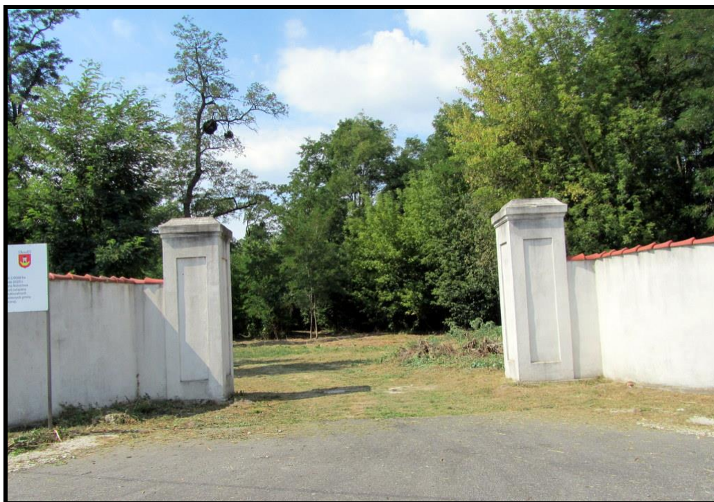
Park i brama wjazdowa z I połowy XIX w.
